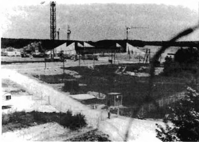
Bunker im "Rohbau" und Baustelleneinfahrt mit "Wachhäuschen"
