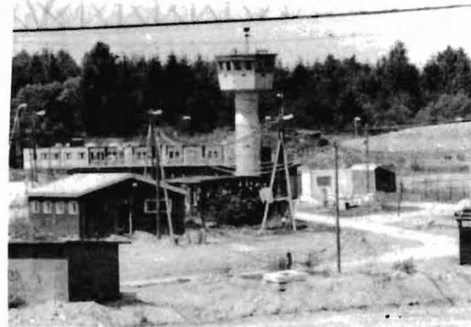
Wachturm der ehemaligen US Nike-Herkules Stellung im Baugelände.
